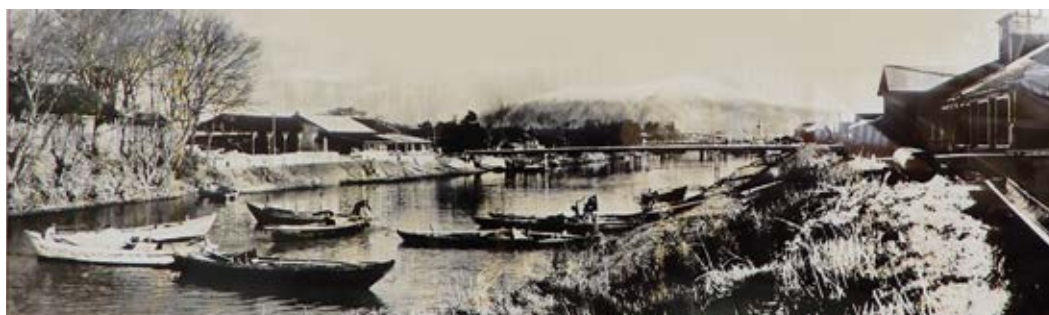
舟でコンクリート製造に必要な砂利などの資材を運ぶ様子
